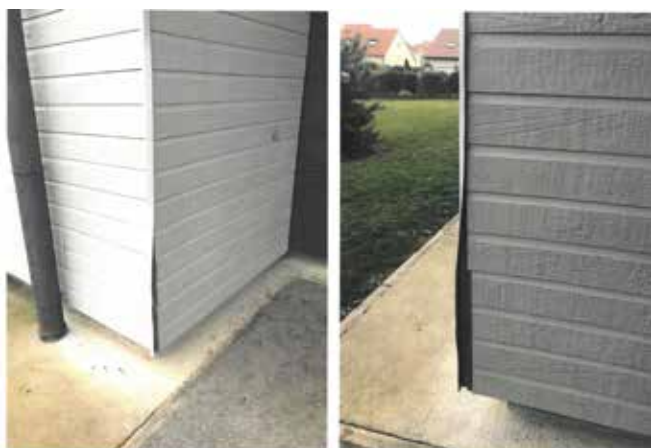
Dégradation au hall sportif sur baguette d'angle.
