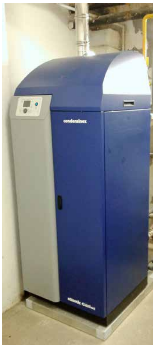
Chaudière à l'école Houpert
