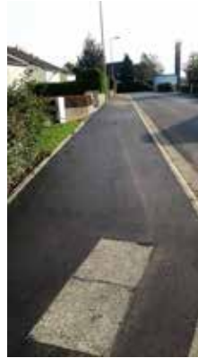
Trottoir rue des Bleuets
